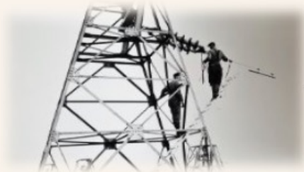
Fornyng av en aldrende anleggsmasse
