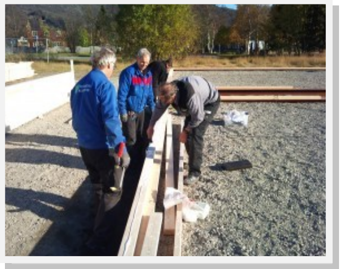
Vaktmestre bygger lavvo
