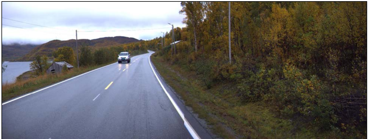
Figur 40. Falleferdig uthus til venstre i bilde lokalisert ved profil 3210 planlegges innløst.
