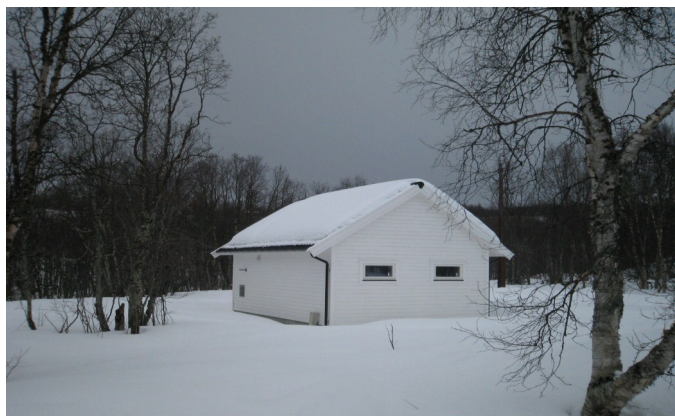
Oksfjord vannbehandling utvendig
