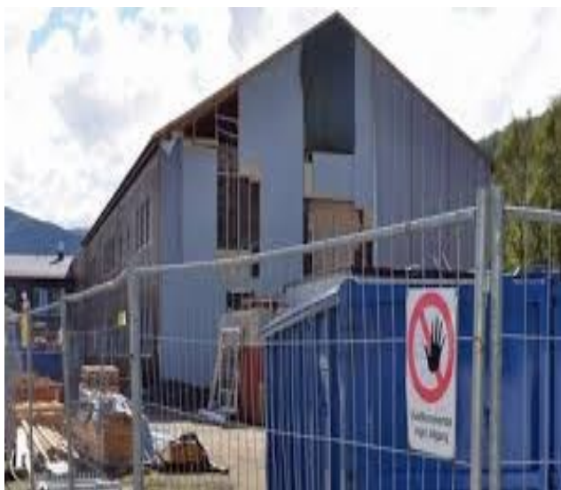
Bygging av ungdomsskolefløy
