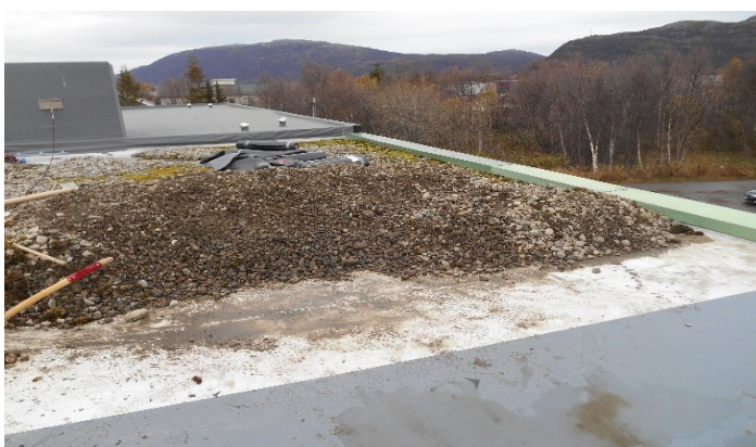
Utskifting av takmembran på kommunehuset.
