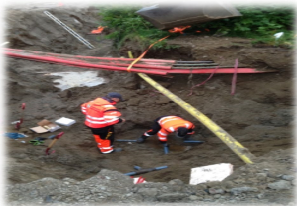
Montering av ny kum Arnestad
