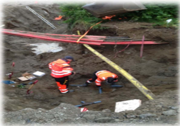
Montering av ny kum Arnestad
