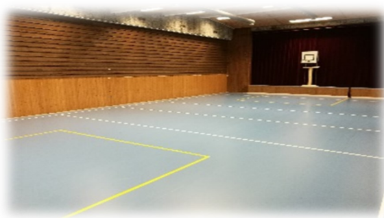
Nytt dekke og igjen kledde vindu på gymsal samfunnshus.
